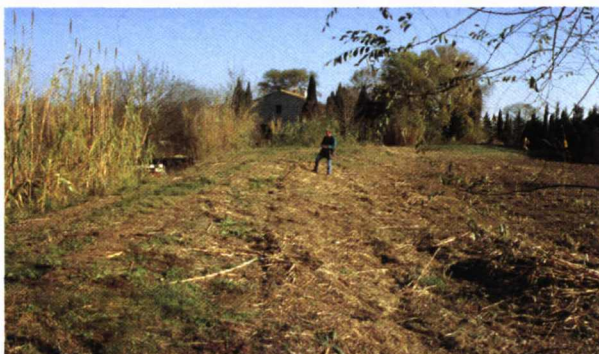
Photo 3.2 – Alignement de laisses de crue sur le talus côté fleuve de la digue de Cuxac-d'Aude, après la crue des 12-13/11/1999.
