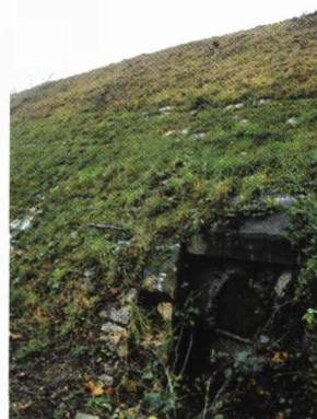
Photo 3.14 – Conduite de rejet, à clapet anti-retour, débouchant en pied du talus côté fleuve de la digue de l'Allier à Moulins.
