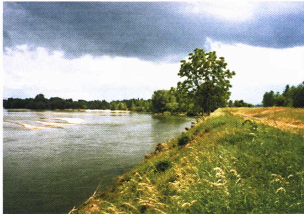
Photo 2.4 – Pied de digue en contact avec le lit mineur de la Loire, dans une courbe concave, sur la levée d'Espagne à la Charité-sur-Loire (Nièvre).
