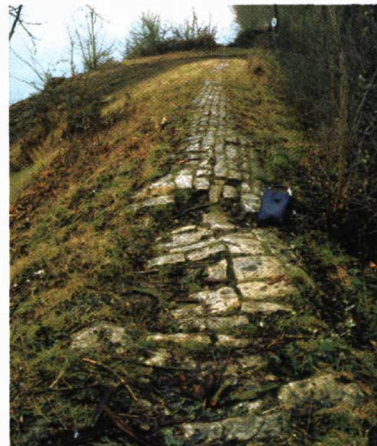
Photo 3.12 – Affaissement du couronnement perreyé de la digue de l'Allier à Moulins (Allier) : indice d'érosion interne et/ou de tassement du remblai.
