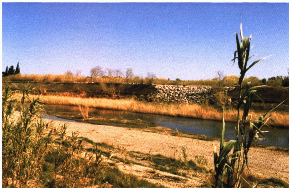
Photo 1.5 – Anciennes protections bétonnées de la berge et du talus côté fleuve de la digue rive droite de l'Agly (Pyrénées Orientales). Réparation récente en enrochements.
