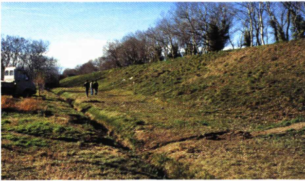
Photo 3.10 – Inspection de la digue du Petit Rhône en Arles après la crue du 8 janvier 1994 : indices de fuite à travers le remblai en pied de talus côté val.
