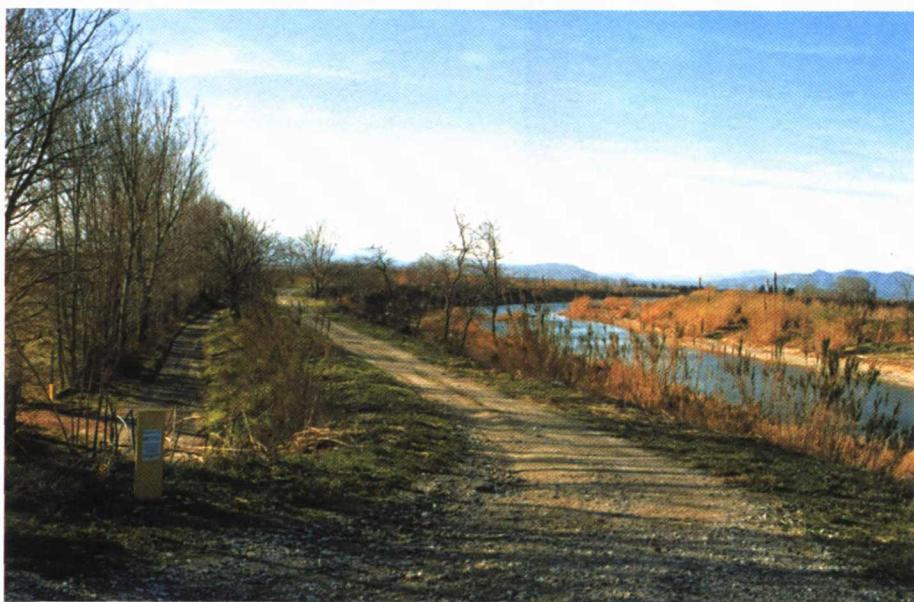
Photo 5.2 – La piste de service en crête – ici localement doublée d'une piste en pied de digue côté val – facilite les opérations de surveillance des digues de l'Agly.
