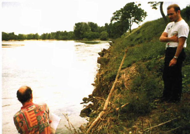
Photo 2.5 – Pied de berge affouillé en contrebas de la levée d'Espagne à la Charité-sur-Loire.
