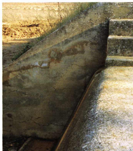
Photo 3.4 – Les déversoirs sont à inspecter minutieusement après les crues. Ici l'empreinte boueuse sur le bajoyer droit permet d'estimer la hauteur maximale de déversement.
