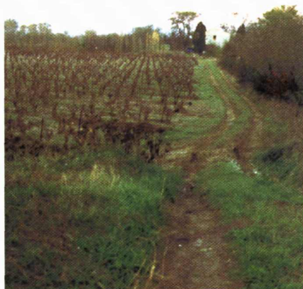
Photo 3.3 – Inspection post-crue de la digue de Cuxac-d'Aude : points bas en crête (passage de chemin) ayant surversé.
