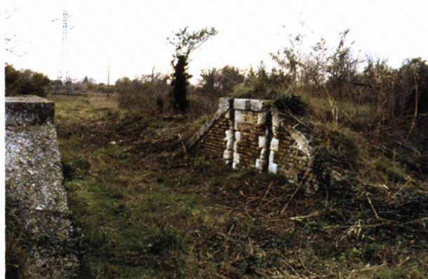
Photo 1.11 – Passage de chemin rural batardable dans la digue rive droite du Grand Rhône à Salins-de-Giraud (Bouches-du-Rhône).
