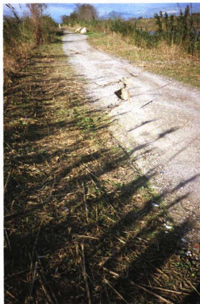
Photo 3.18 – Fissure apparue en crête de digue à la décrue de l'Agly en novembre 1999 – signe d'une instabilité du talus côté fleuve à la vidange rapide.
