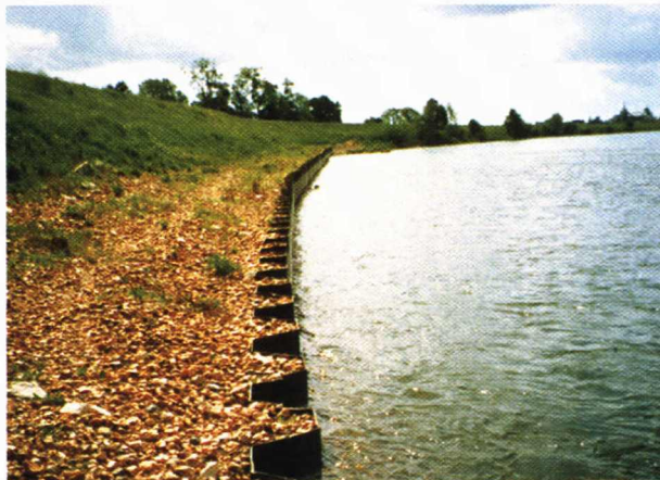
Photo 6.11 – Protection du pied de la levée rive gauche de St-Benoît (Loiret) par rideau de palplanches.
