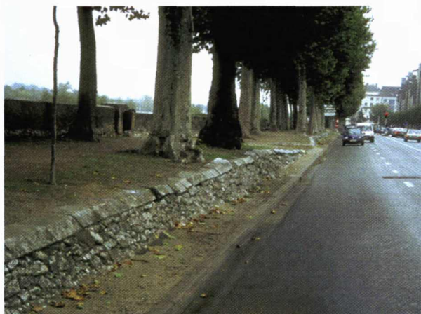
Photo 5.3 – Les racines des arbres déforment, et parfois même démantèlent, les maçonneries situées à proximité (quai de la Loire à Tours).
