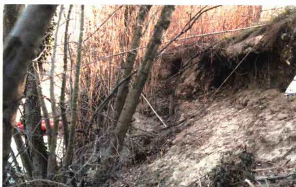
Photo 3.16 – Escarpement et arbres inclinés en berge ou sur le talus côté fleuve de la digue sont le signe d'une instabilité d'ensemble à la décrue.
