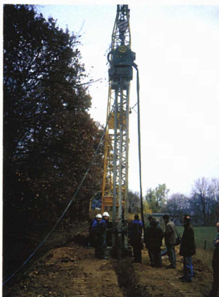
Photo 6.12 – Construction d'une paroi moulée étroite pour étancher le corps d'une digue (levée de l'Oder en Pologne).
