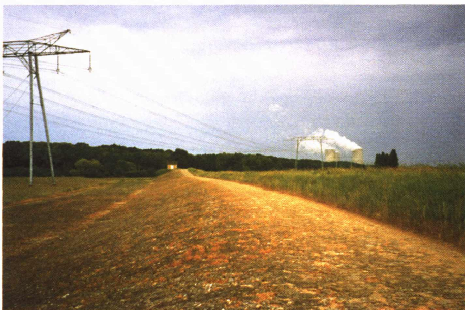
Photo 1.7 – Déversoir en maçonnerie de pierres d'Ouzouer-sur-Loire (Loiret), équipé d'une banquette fusible (cordon de terre enherbé, à droite sur la photo).
