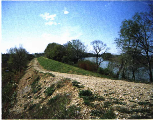
Photo 6.9 – Recharge drainante aval construite après la crue du 8 janvier 1994 sur la digue du Petit Rhône en Arles. Piste de service aménagée au sommet de la recharge – la crête de digue demeurant non carrossable.
