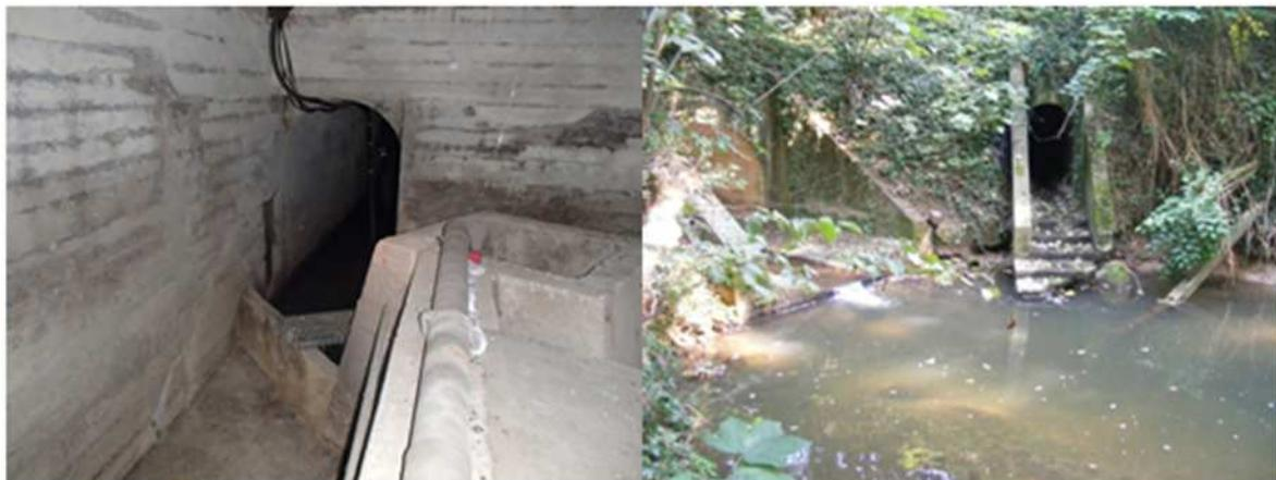
Figure D-22 : Le déversoir d'orage d'Ecully et le milieu récepteur associé
