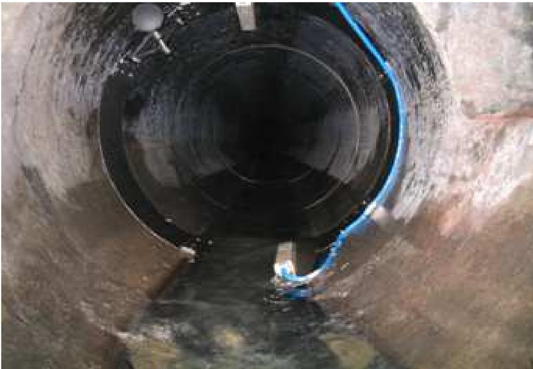
Figure C-6 : Profilomètre posé dans une canalisation à surface libre
