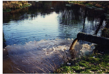
Rejet d'eau usée non traité dans la Mauldre (source : http://www.siarnc.fr )
