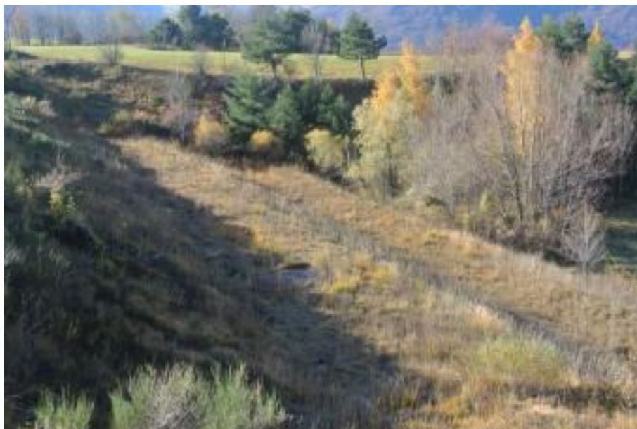
Figure 133. Vue du talus aval et de la végétation arborescente en rive gauche du barrage des B... (France - 05) (photo : Bambara G., 2014)
