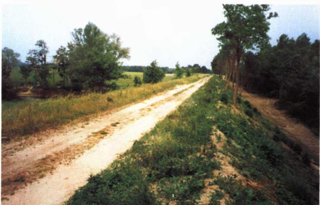
Photo 3 : Levée d'Espagne en amont de La Charité-sur-Loire - profil assez étroit, simple chemin de service en crête.
