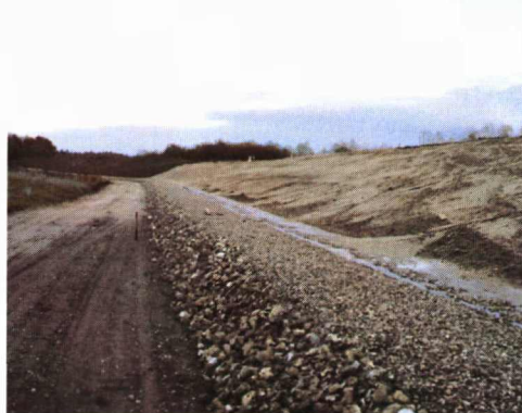
Photo 5 : Chantier de renforcement côté val sur la levée du Val de Bou (45) - remblayage en cours du talus côté val sur le tapis drainant.
