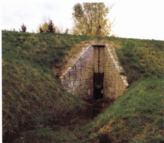
Photo 14 : Ouvrage vanné de traversée sur la levée du Val de Bou (45), vu depuis le val.
