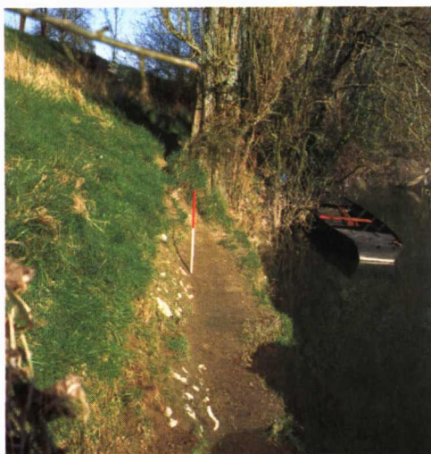
Photo 7 : Affleurement d'un ancien perré de protection sur la berge de la levée rive droite du Cher à Savonnières (37).
