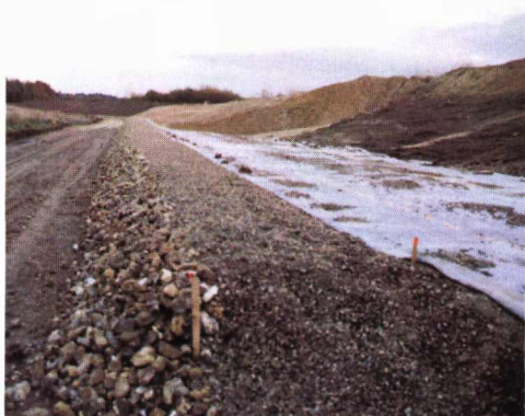
Photo 4 : Chantier de renforcement côté val sur la levée du val de Bou (45) - tapis drainant recouvert d'un géotextile anti-contaminant.
