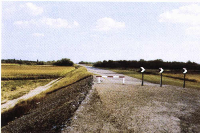
Photo 1 : Déversoir de Jargeau (45) sur la levée de Loire rive gauche, vu depuis l'aval.
