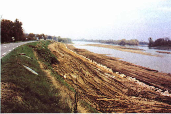
Photo 10 : Chantier de renforcement côté Loire sur la levée rive droite de Fondettes-Luynes.
